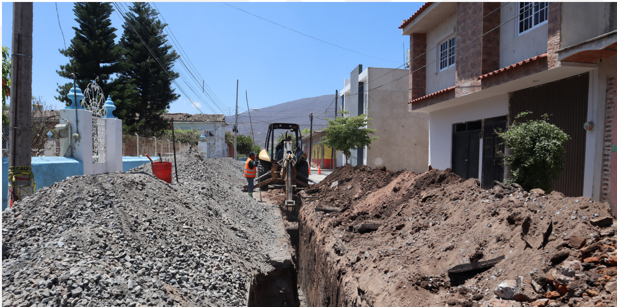
Reparación de red de drenaje en la calle Zaragoza
