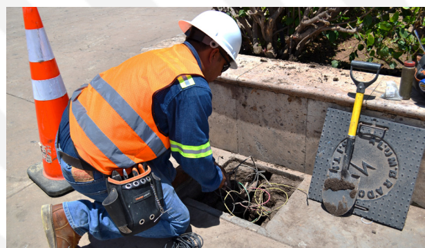
Personal de alumbrado público dando mantenimiento
