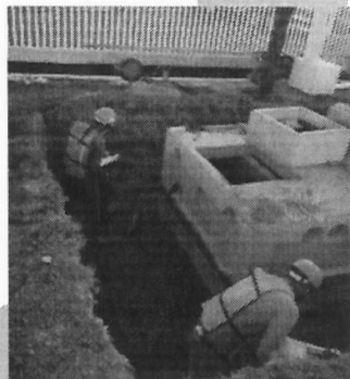
Relleno perimetral y compactación
