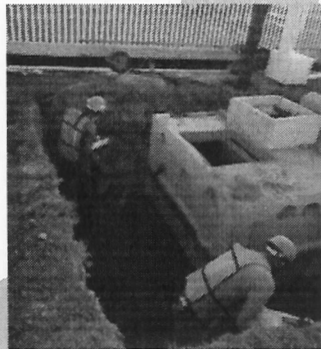
Relleno perimetral y compactación
